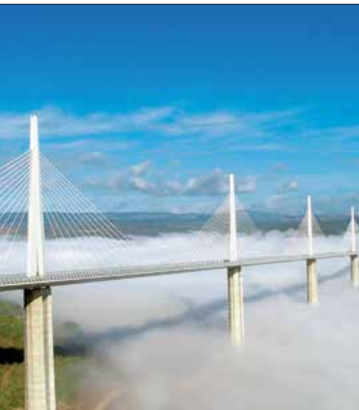
▲ Fot. 1. Most Millau, Francja – izolacja w technologii Icopal
