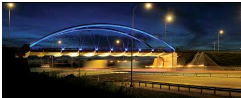
▲ Fot. 2. Wiadukt w Nowym Dworze Gdańskim – izolacja z papy Supermost w technologii Icopal
