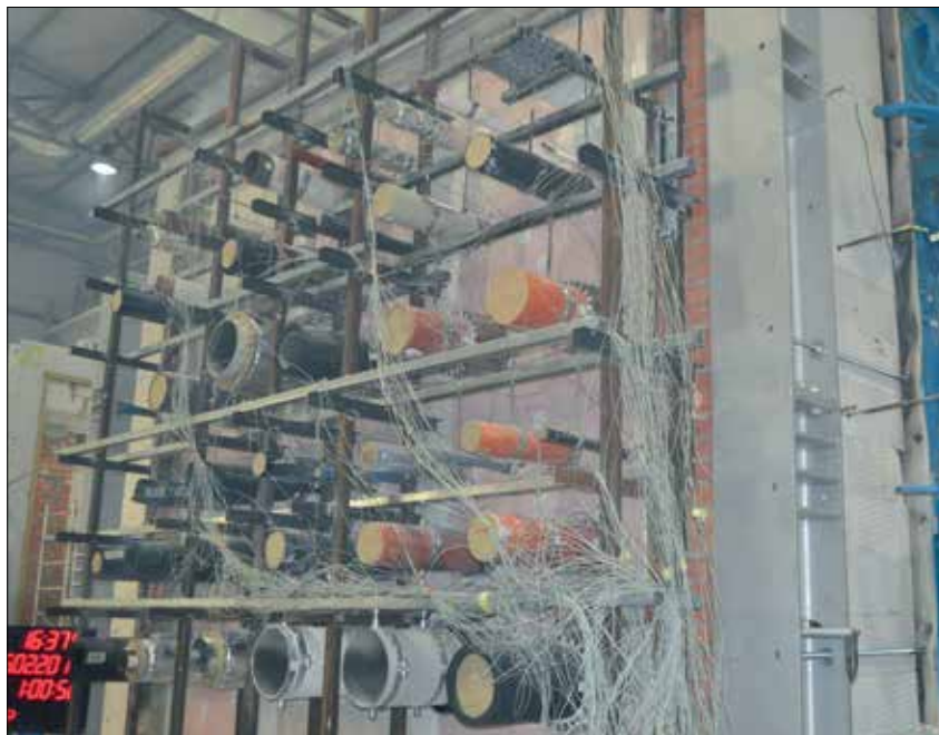
▲ Fot. 1. Widok nienagrzewanej powierzchni elementu próbnego w trakcie badania w zakresie odporności ogniowej (uszczelnienia przejść rur do instalacji ogólnobudowlanych w ścianie)
