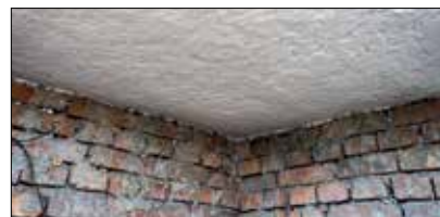
▲ Fot. 2. Ocieplenie stropów piwnic w budynkach mieszkalnych wspólnot i spółdzielni mieszkaniowych
