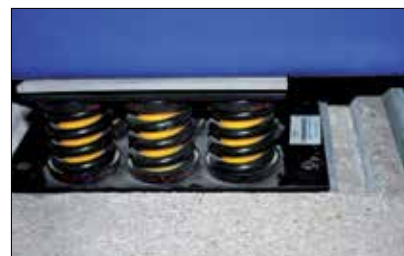
▲ Izolatory sprężynowe do efektywnej izolacji drgań
