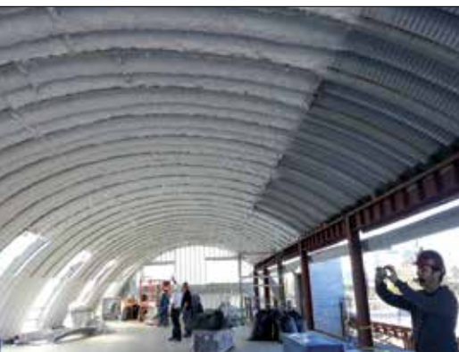
▲ Fot. 1. Rewitalizacja przestrzeni przemysłowych
