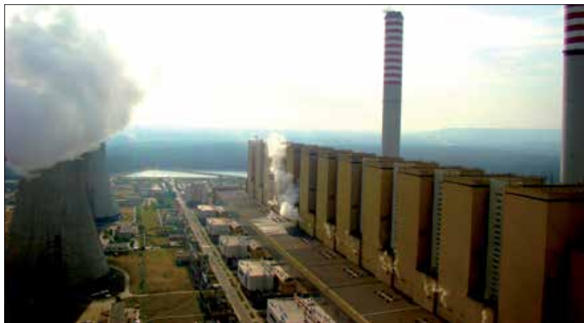
▲ Fot. 1. Izolacje kotłów, kanałów i rurociągów przykottowych podczas modernizacji bloków 5, 7, 8, 11, 12, 9, 10 w Elektrowni Bełchatów
