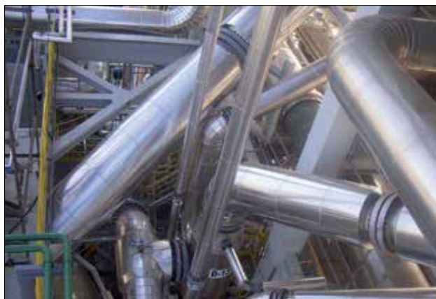
Fot. 3. ► Budowa wytwórni kwasu tereftalowego
