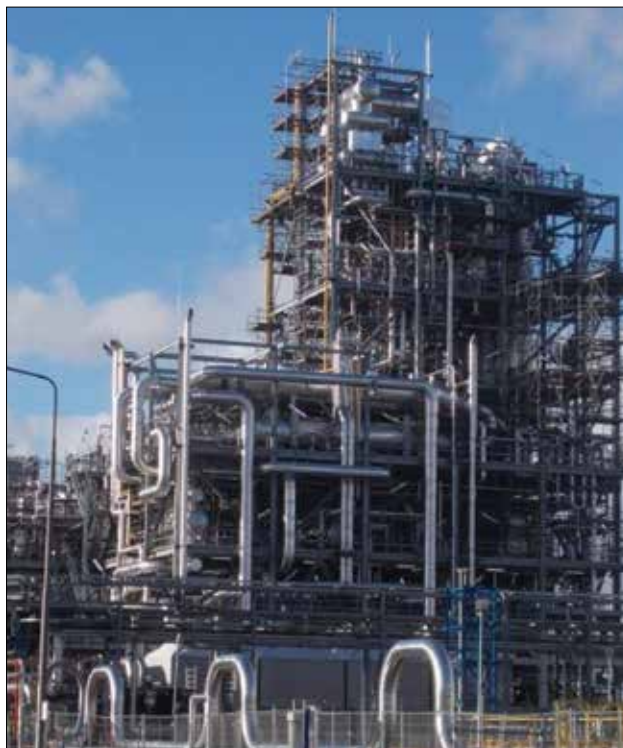
Fot. 2. ► Budowa wytwórni kwasów tłuszczowych w Rotterdamie
