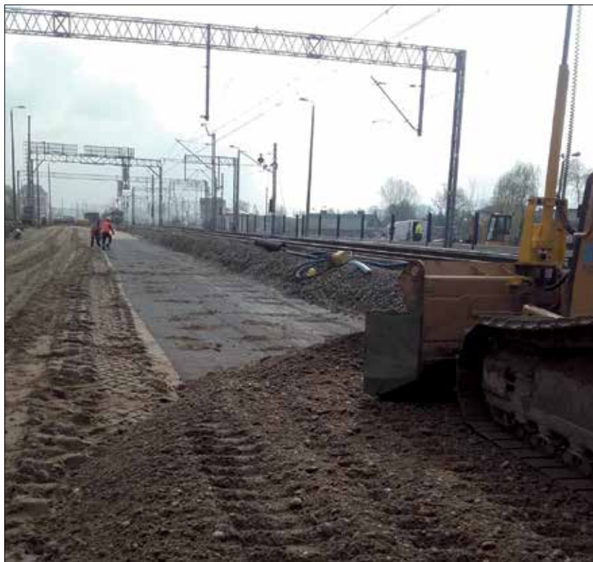
▲ Fot. 4. Układanie geosyntetyków w podtorzu
