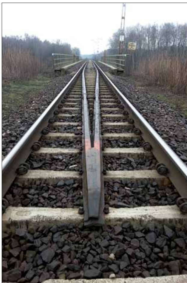
Fot. 4. ► Przykład nawierzchni o konstrukcji podsytkowej z zastosowaną odbojnicą
