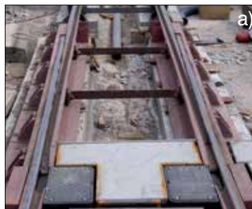
Fot. 3. ► Przyrząd wyrównawczy z ciągłą krawędzią toczną: a) pojedynczy, b) podwójny
