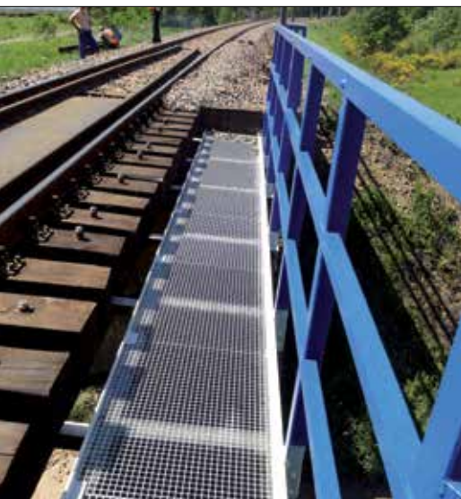
▲ Fot. 1. Przykład obiektu z nawierzchnią kolejową na mostownicach
