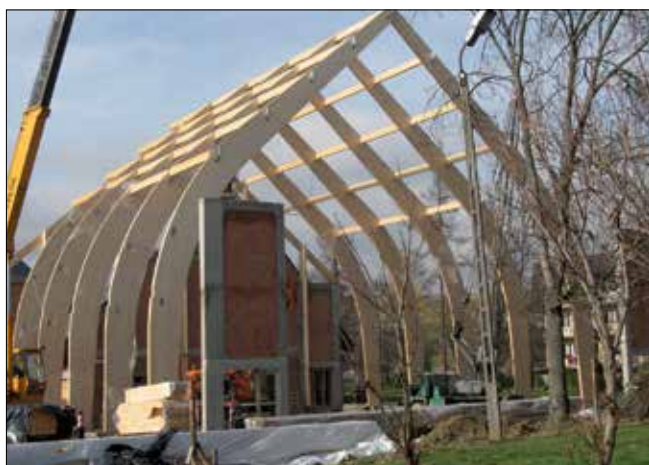
Fot. 2. Przykładowa konstrukcja z drewna klejonego
