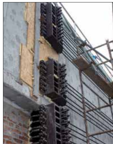
Fot. 1. Przykład naprawy zbiornika za pomocą cięgien sprężających zewnętrznych [7]
