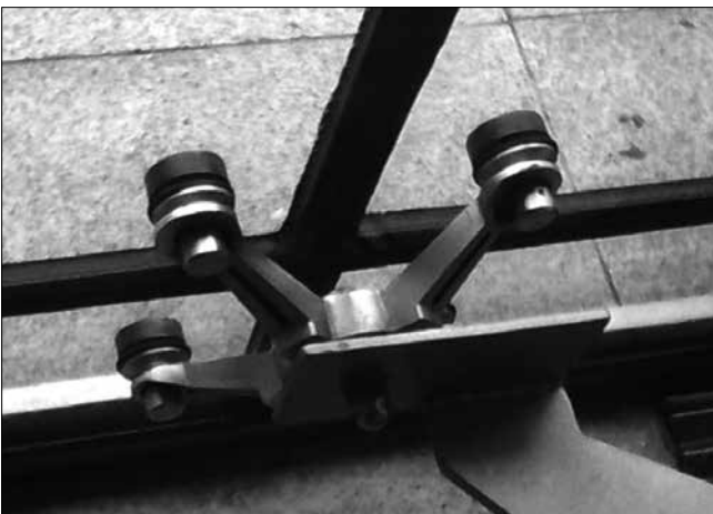
Fot. 1. Rotule do punktowego mocowania szkła (fot. autora)
