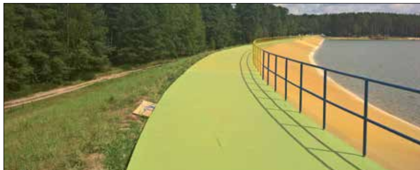
▲ Fot. 2. Renowacja ciągu komunikacyjnego na zaporze
