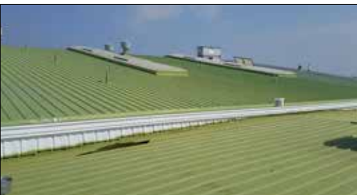
▲ Fot. 1. Renowacja pokrycia dachu z blachy
