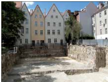
Zabezpieczenie wykopu palisadą z przesłoną poziomą „jet grouting”, Wrocław
