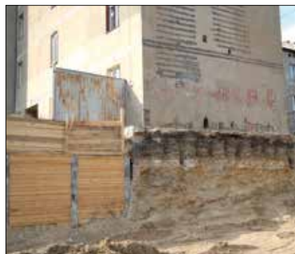
Palisada z kolumn „jet grouting”, Łódź
