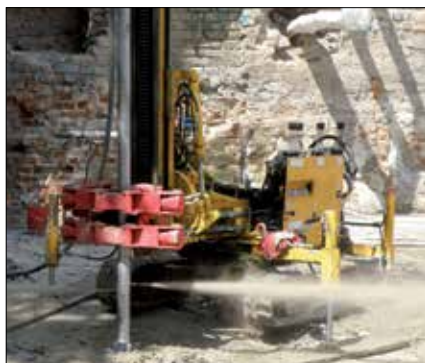
Strumień wycinający kolumnę „jet grouting”
