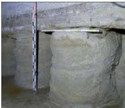
Kolumny uformowane pod istniejącym fundamentem
