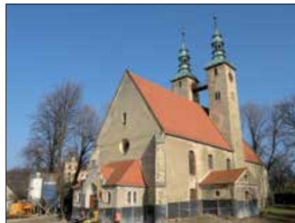
Wzmocnienie posadowienia kościoła palami „jet grouting”, Stolec
