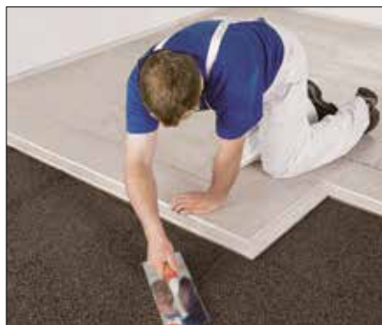
Układanie suchego jastrychu na keramzytce
