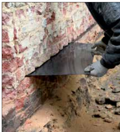
2. Wkładanie izolacyjnej płyty polietylenowej PE-HD
