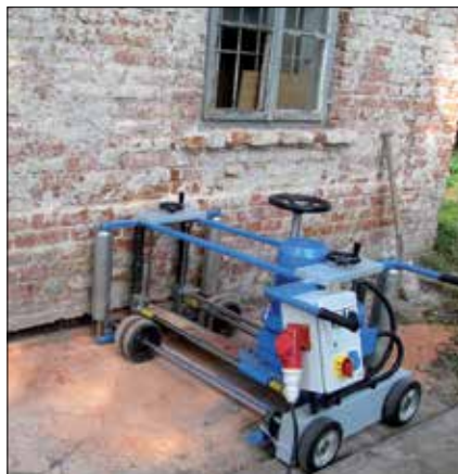
1. Cięcie ściany samojezdną piłą łańcuchową PMS
