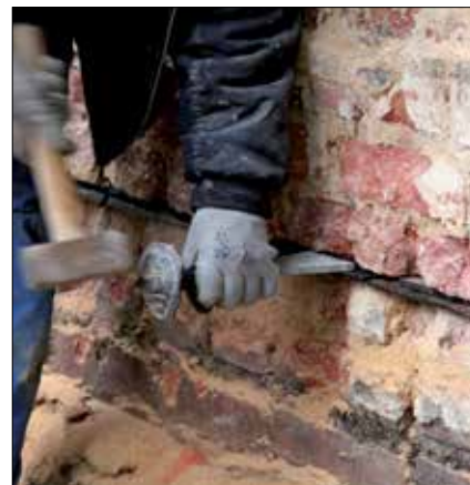
3. Wbijanie klinów zapobiegających osiadaniam ścian
