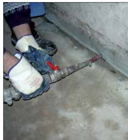
4. Wtłaczanie pod ciśnieniem zaprawy cementowej
