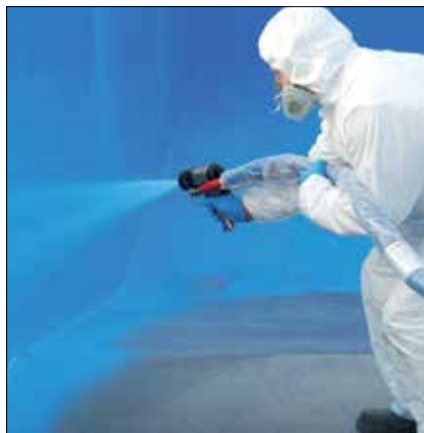
Aplikacja systemu Almacoat wewnątrz basenu
