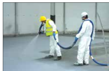
Aplikacja systemu Almacoat na powierzchni hali przemysłowej
