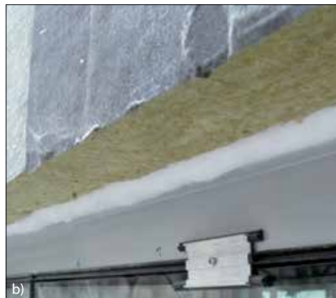
Fot. 6. Przykładowy asortyment i zastosowanie porogelu: a) pojedyncza mata porogelu [11], b) mata z porogelu podczas montażu [14]
