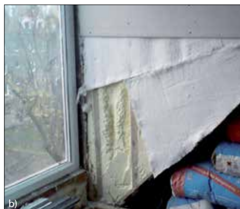
Fot. 5. Przykładowy asortyment i zastosowanie aerożelu: a) przykładowe produkty z aerożelu [11], b) maty z aerożelu użyte przy ociepleniu ościeży okiennych [9]
