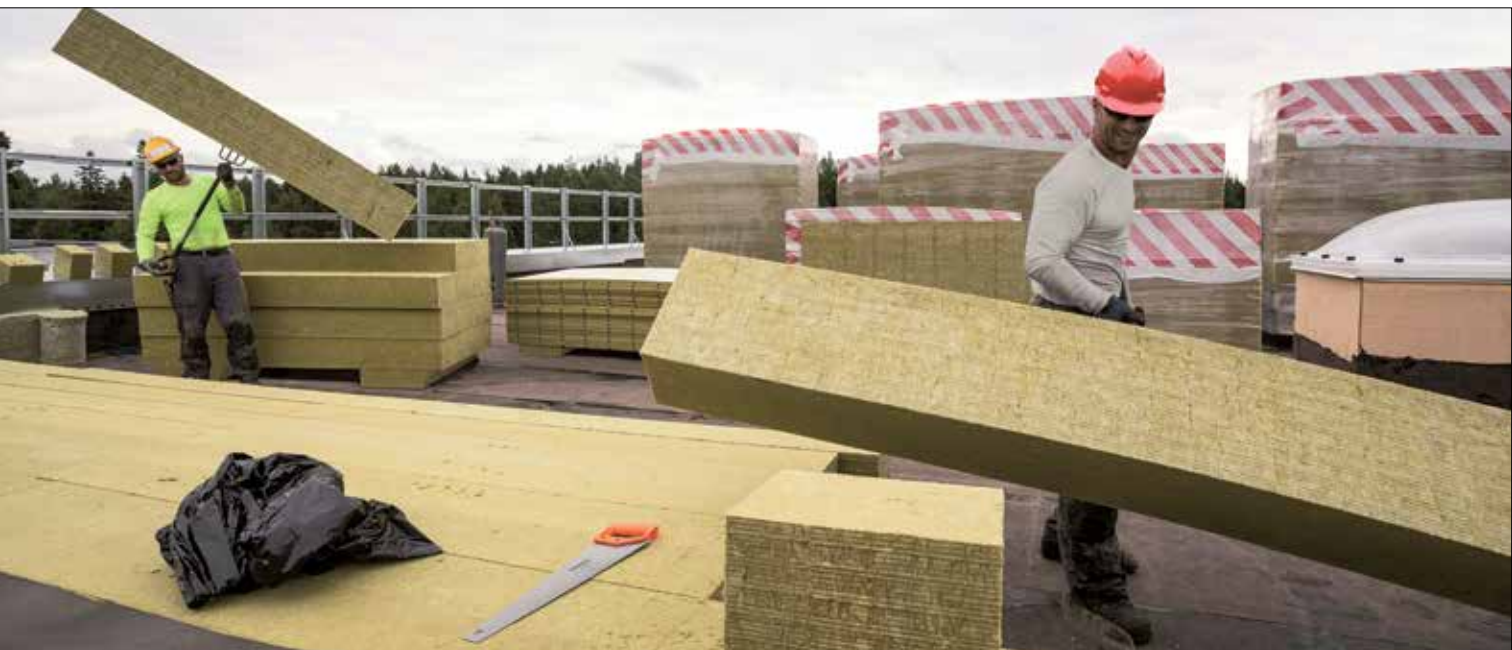
Fot. 1. Montaż systemu PAROC PROOF jest łatwy i szybki – wykonywać go może jedna osoba
