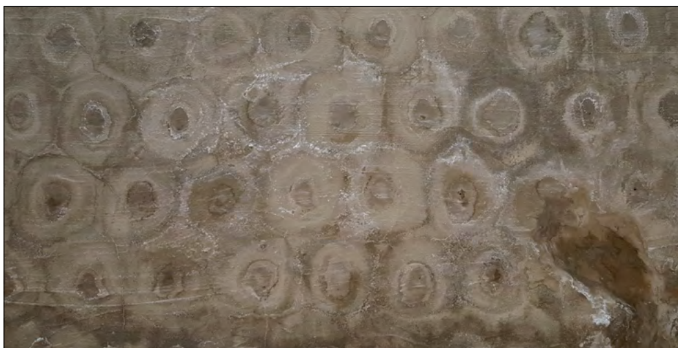
Fot. 2. Przykład realizacji geometrii otworów iniekcyjnych dla izolacji pionowej przeciwwilgociowej w technologii Iniekcji Krystalicznej®
