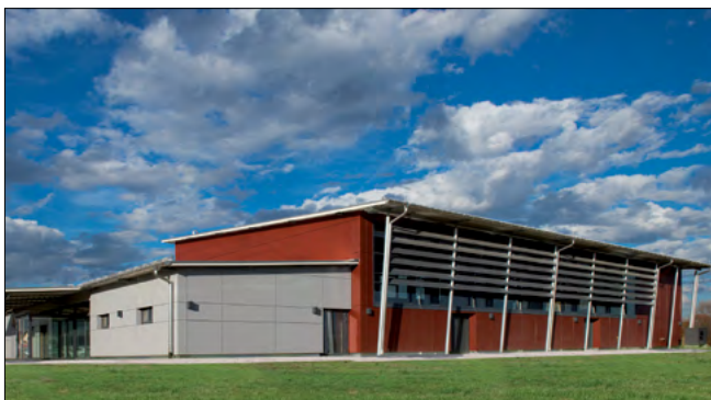
Fot. Hala wielofunkcyjna w miejscowości Volkertshausen – elewacja wentylowana wykonana z zastosowaniem kotew Schöck Isolink TA-S (zdjęcie od Schöck Bauteile GmbH)
