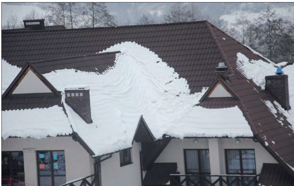
Fot. 1. Forma dachu i jej wpływ na obciążenie śniegiem
