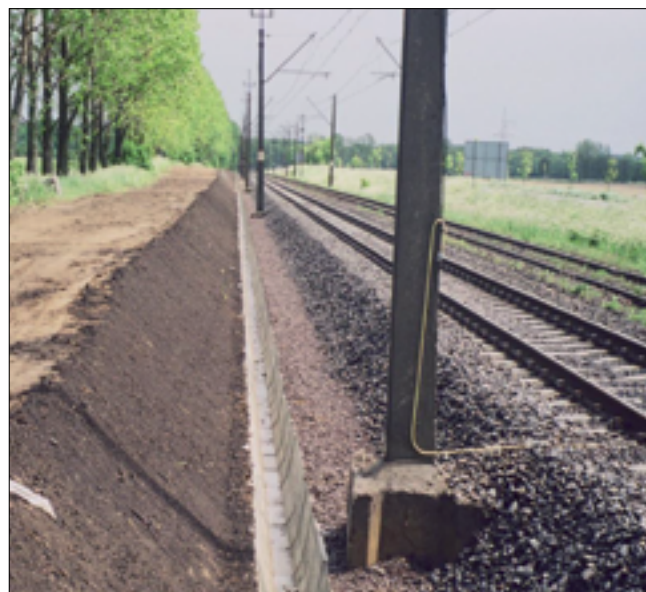
Fot. 3. Rów umocniony korytkami krakowskimi
