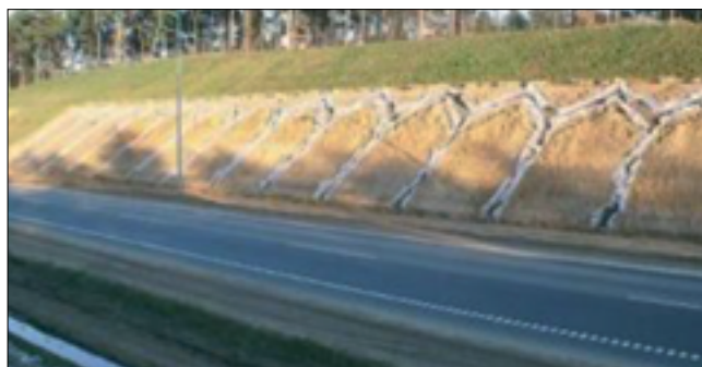
Fot. 6. Drenaż skarpowy przyporowy na skarpie drogowej
