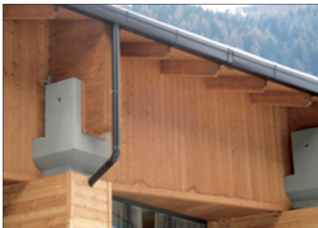
Fot. 2. Przykład usztywnienia dźwigara na podporze
