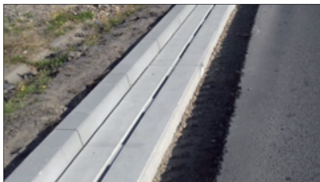
Fot. 5. Ściek szczelinowy
