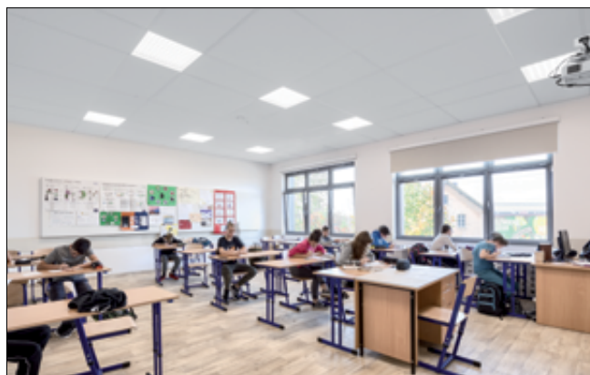
Fot. 1. Sala lekcyjna – dźwiękochłonny sufit podwieszany oraz panele ściennne na tylnej ścianie (używane jako gazetka ścienna). Fot.: Tomasz Osiak
