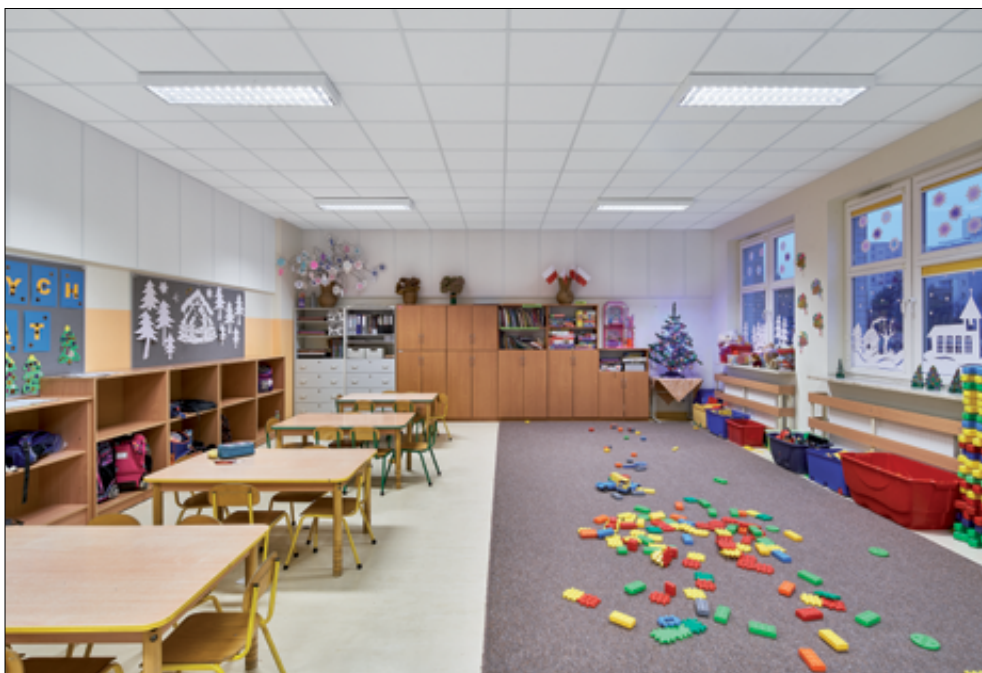
Fot. 4. Świetlica szkolna – dźwiękochłonny sufit podwieszany oraz panele ściennie instalowane na dwóch przyległych ścianach od wysokości ok. 200 cm. Instalacja paneli ściennych tuż pod sufitem była wymuszona przez istniejące umeblowanie modernizowanej sali. Fot.: Bartosz Makowski
