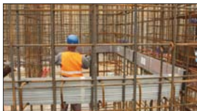
▲ Fot. 2. System zbrojenia odginanego BINDAX
