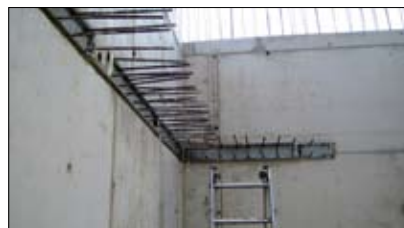
▲ Fot. 3. System zbrojenia odginanego BINDAX
