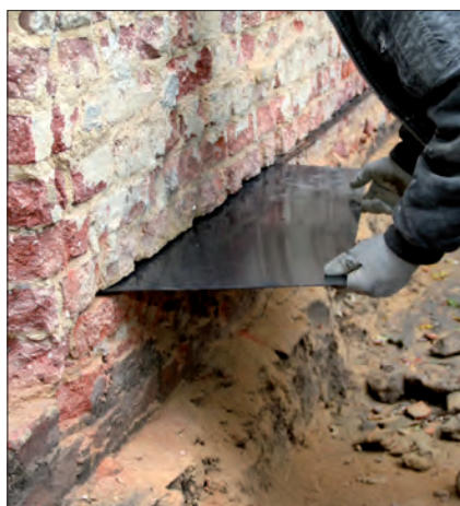
2. Wkładanie izolacyjnej płyty polietylenowej PE-HD
