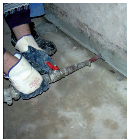
4. Wtłaczanie pod ciśnieniem zaprawy cementowej
