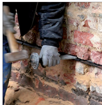
3. Wbijanie klinów zapobiegających osiadaniu ścian
