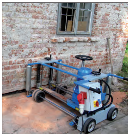
1. Cięcie ściany samojezdną piłą łańcuchową PMS
