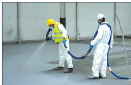
Aplikacja systemu Almacoat na powierzchni hali przemysłowej
