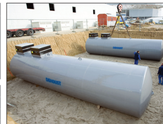
Zbiorniki stalowe podziemne
