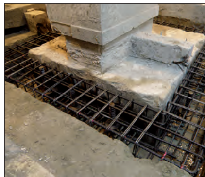
Wzmocnienie posadowienia stopy mikropalami, Wrocław
