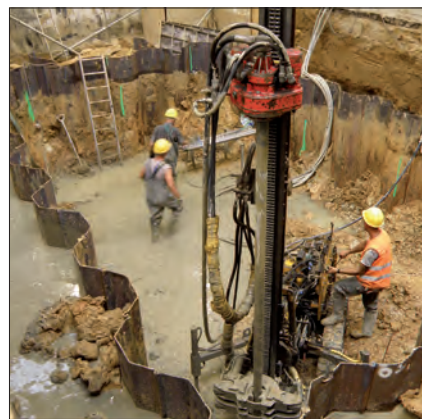
Posadowienie fundamentu maszyny na palach „jet grouting”, Legnica
