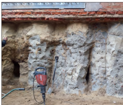
Podbicie istniejących fundamentów kolumnami „jet grouting”, Konstancin
