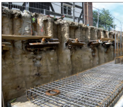
Zabezpieczenie wykopu kotwioną palisadą z kolumn DSM, Wrocław
