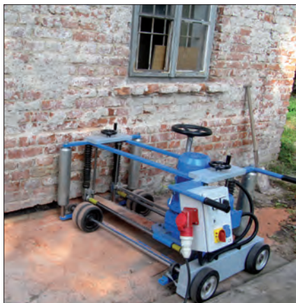
1. Cięcie ściany samojezdną piłą łańcuchową PMS
