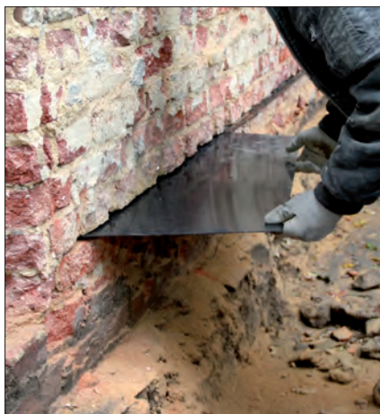
2. Wkładanie izolacyjnej płyty polietylenowej PE-HD
