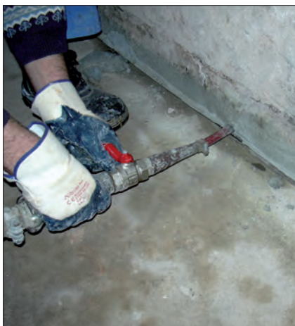
4. Wtłaczanie pod ciśnieniem zaprawy cementowej
