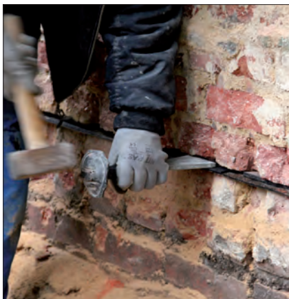
3. Wbijanie klinów zapobiegających osiadaniam ścian
