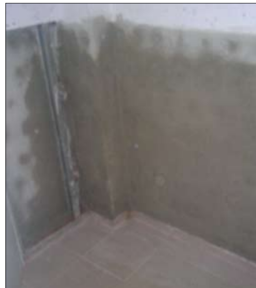
▲ Fot. 2. Izolacja pionowa przeciwwilgociowa w technologii Iniekcji Krystalicznej® – w dniu wykonania
