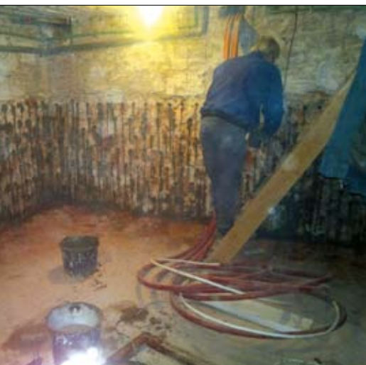
▲ Fot. 1. Wykonywanie pionowej izolacji przeciwwilgociowej w technologii Iniekcji Krystalicznej®
