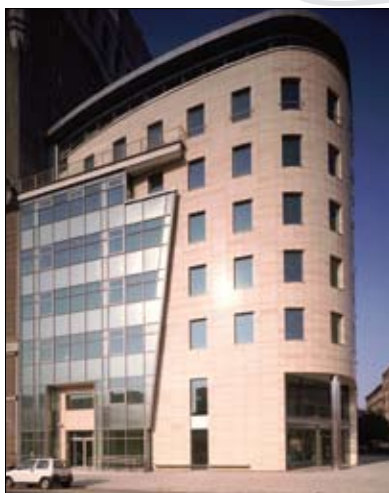
Biurowiec Zielna Point w Warszawie
