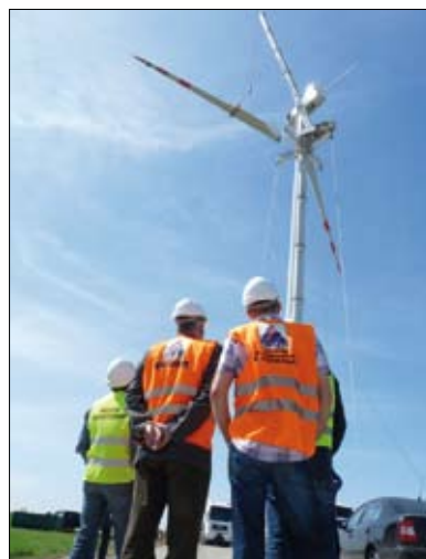
Budowa farmy wiatrowej w gminie Błaszk
