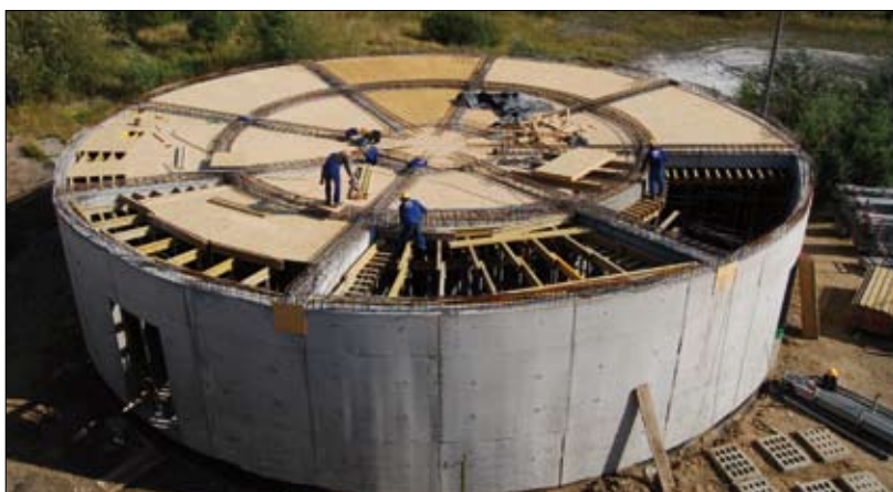
Budowa dekantera solanki z instalacją technologiczną
