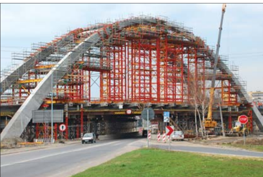
Budowa wiaduktu nad ul. Trzebińską, Chrzanów, 2013 r.
