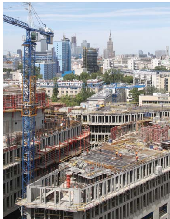
Budowa biurowca Plac Unii, Warszawa, 2012 r.
