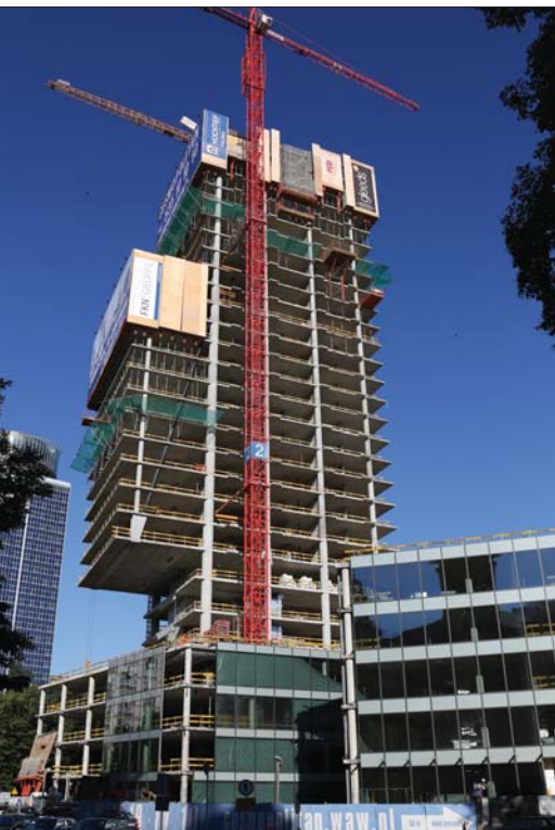
Budowa wieżowca Cosmopolitan, Warszawa, 2012 r.
